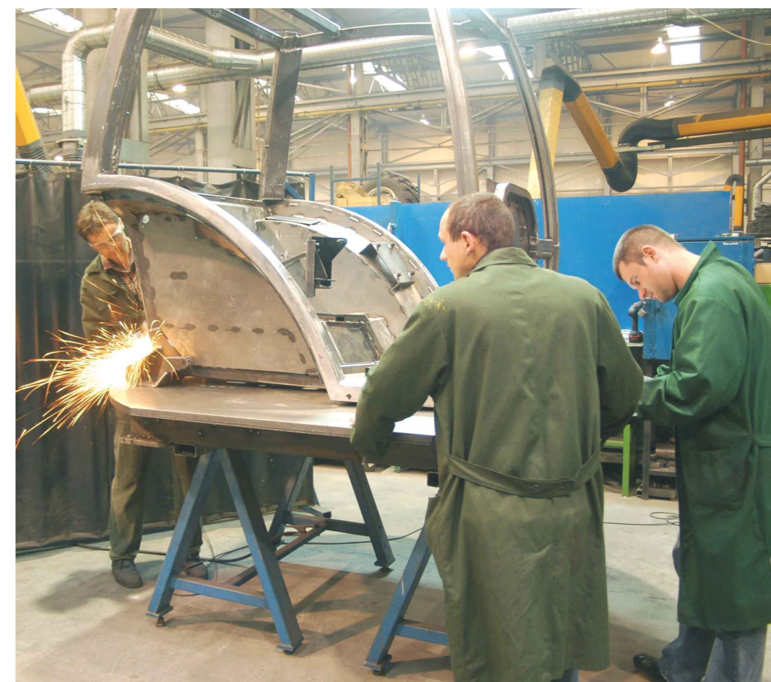
Ostatnie poprawki przed oddaniem konstrukcji ochronnej do malowania wykonuje Andrzej Onopiuk z Prototypowni
